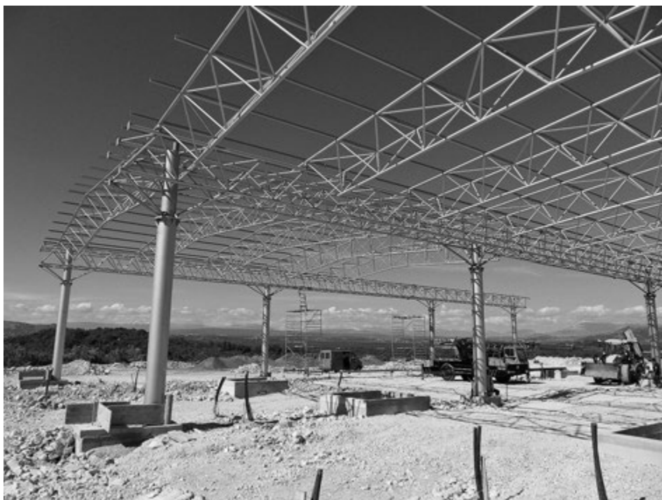
Slika 4. Izgradnja središnje nadstrešnice
