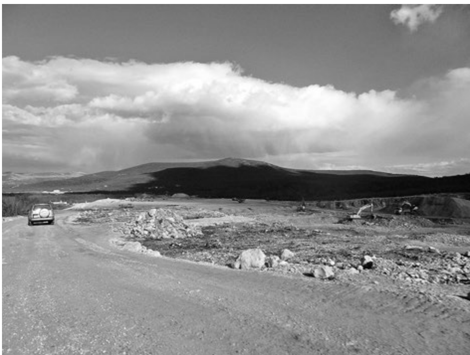
Slika 2. Gradilište na početku radova
