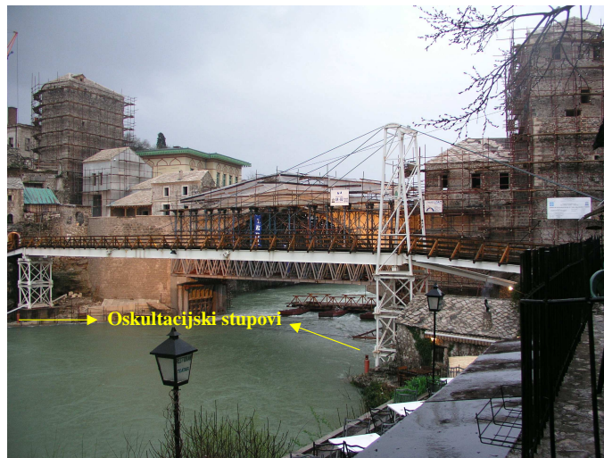
Slika 1: Oskultacijski stupovi na uzvodnoj strani Starog mosta
